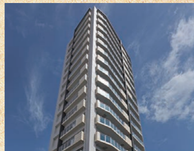
プレサンスロジエ浦添城間ヴォール 総戸数/全32戸 2021年4月竣工
