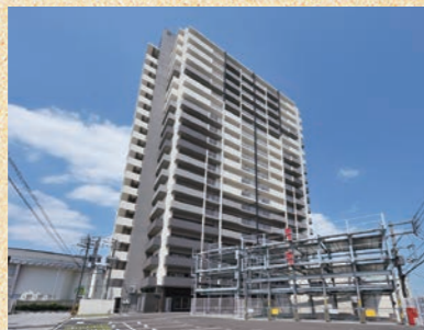
プレサンスロジエ牧港レーヴタワー 総戸数/全72戸 2019年4月竣工
