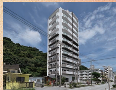
プレサンスロジエ浦添牧港ヴォール 総戸数/全21戸 2022年4月竣工
